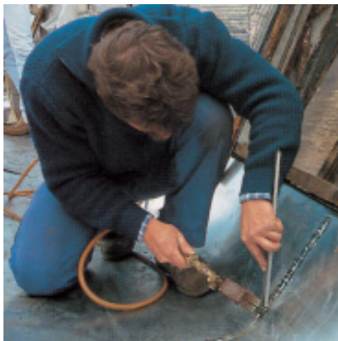
Foto: Brandt Edelstahldach GmbH, Köln
