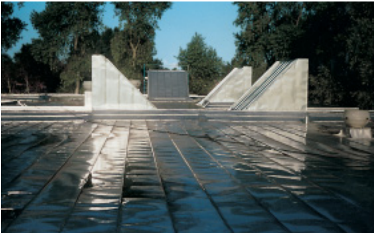
Standardutförandet i finish 2B är en kostnads-effektiv lösning för platta tak
