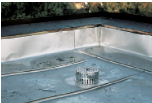
Förtillverkad takbrunn (övre) Installerad takbrunn, komplett med lövsil (undre)
