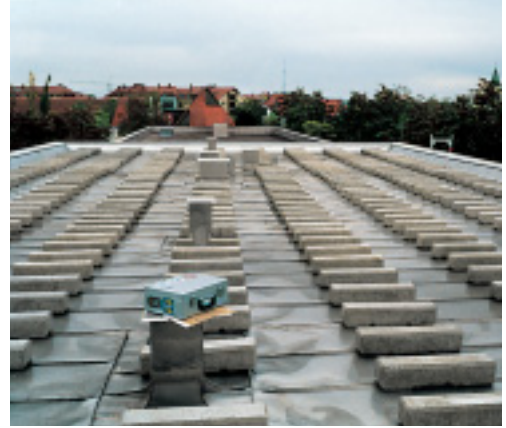
Taktäckningen kan fixeras med klammer eller genom viktbelastning.
